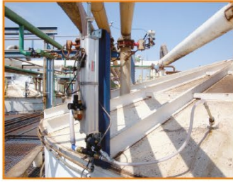
Instalação do dosador individual nas dornas de fermentação
