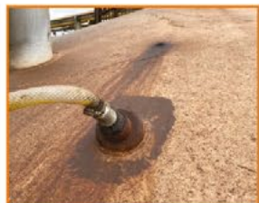
Bico injetor de antiespumante Pico inyector de antiespumante
